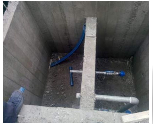
Şalpazarı ilçesi Sayvançatak Mahallesi İçme suyu depo inşaatı
