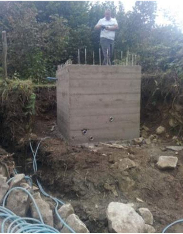
Maçka İlçesi Bahçekaya Mah. Demirciler Mevki içme suyu inşaatı
