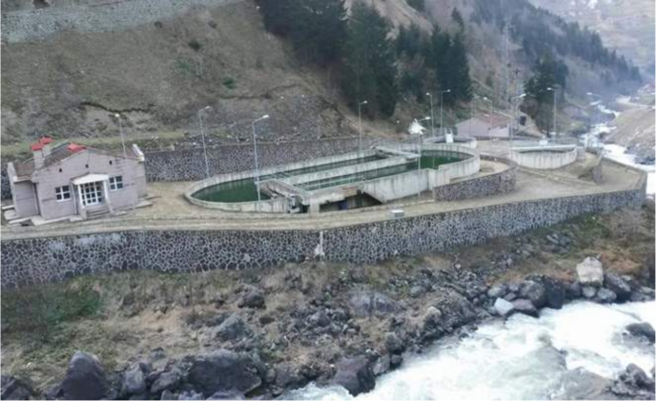
Çaykara-Uzungöl Biyolojik Atıksu Arıtma Tesisi
