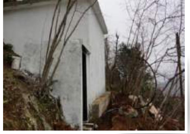
Arsin ilçesi Yeşilköy Mah. (Kerimoğlu mevki) İçme suyu isale hattı ve depo inşaatı
