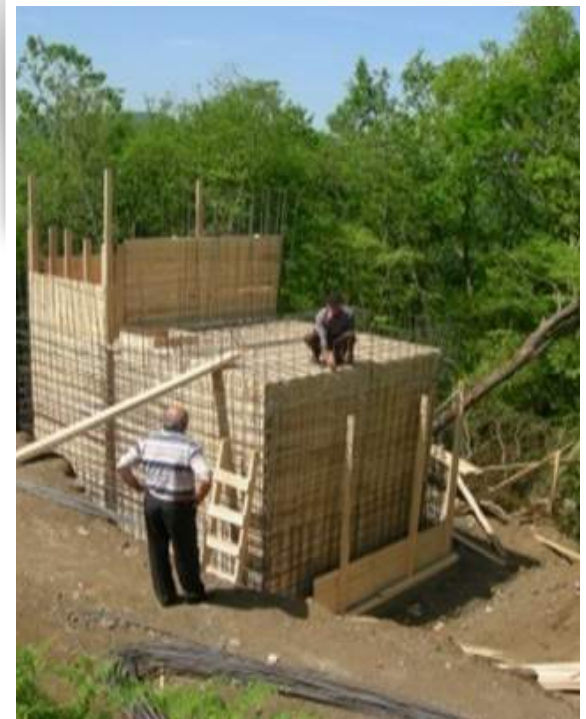
Kaymaklı Mahallesi İçme Suyu ana İsale Hattı ve Şebeke İnşaatı
