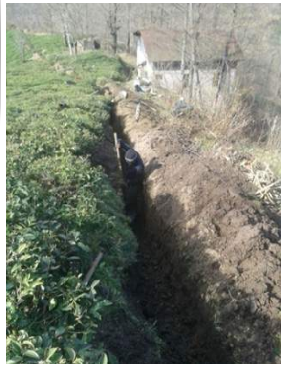
Yemişalan Mahallesi İçme Suyu Terfi İkmal-Onarım İnşaatı
