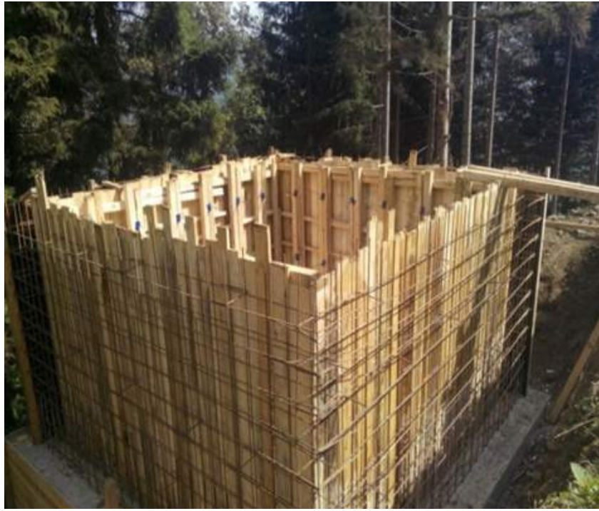
Şalpazarı İlçesi Tepeağzı Mahallesi içme suyu depo inşaatı
