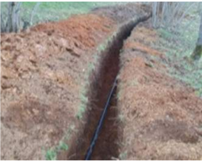
Fındıklı Mahallesi İçme suyu Şebeke İnşaatı
