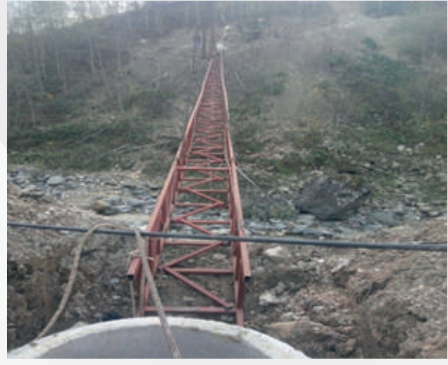
Tonya Merkez Atıksu Şebeke ve Ana Kolektör Hattı Yapım Projesi (%50 Sukap)
