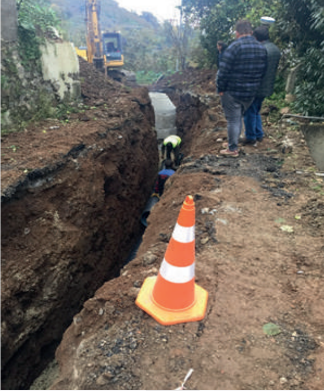
İlçelerde Yapılan Kanalizasyon Hattı Yapım İşleri
