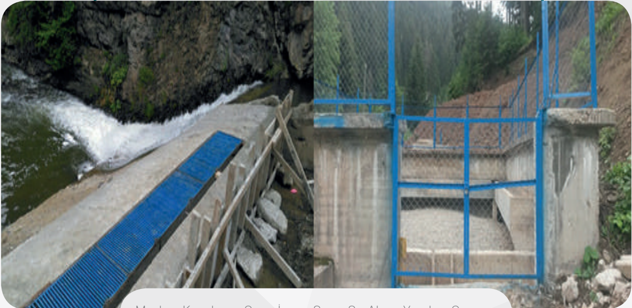
Merkez Karakaya Grup İçme Suyu Su Alma Yapıları Onarım
