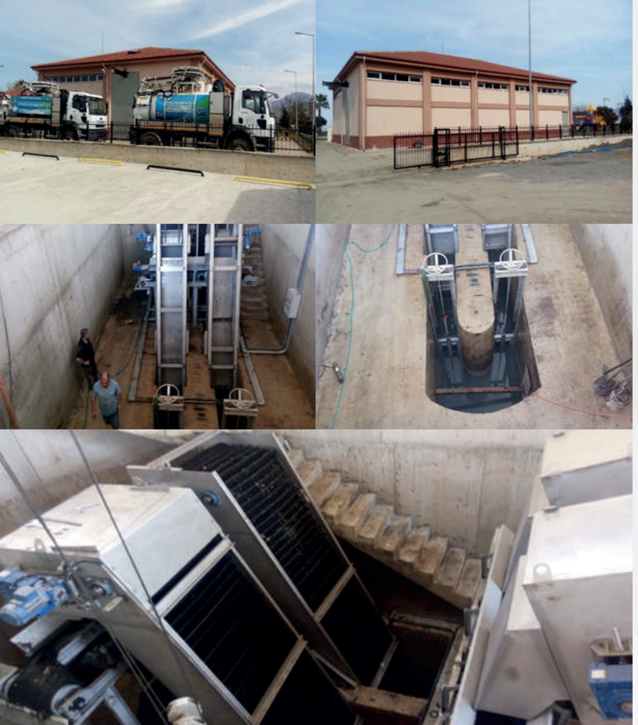
Araklı-Beşikdüzü Kanalizasyon ve Derin Deniz Deşarjı İnşaatı
