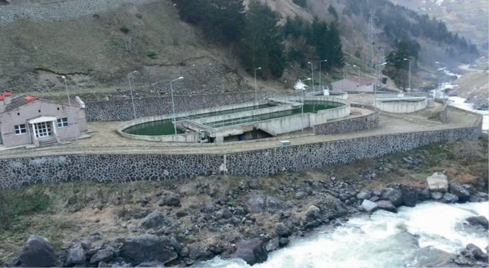
• Uzungöl Atık Arıtma Tesisi
