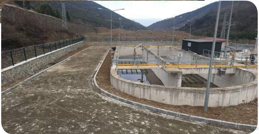
Fotoğraf- 106 Atasu Biyolojik Atık Su Arıtma Tesisi
