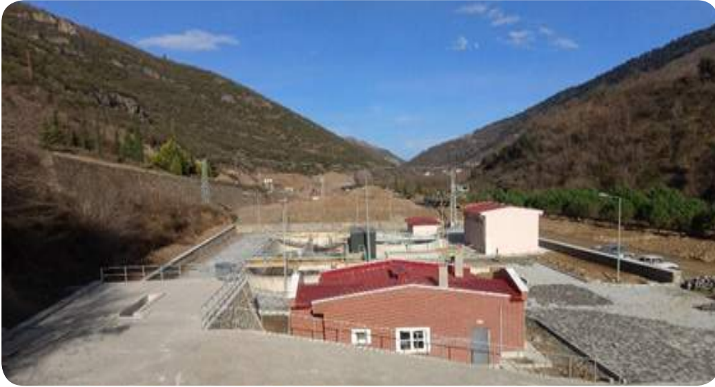
Fotoğraf- 159-160-161 Atasu Biyolojik Atık Su Arıtma Tesis
