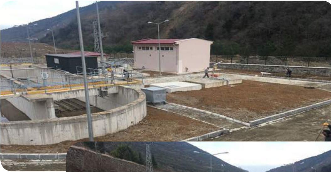
Fotoğraf- 105 Atasu Biyolojik Atık Su Arıtma Tesisi
