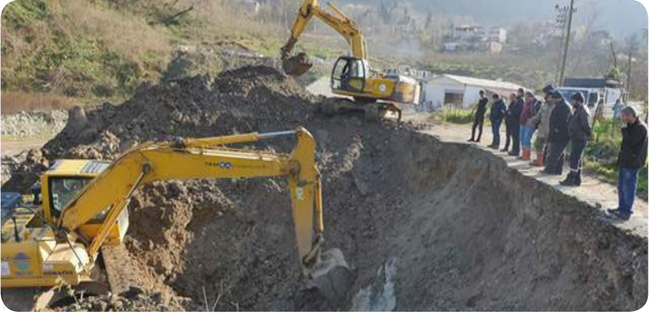
Fotoğraf- 53 Ana isale hattı üzerinde meydana gelen arıza giderme çalışması-1
