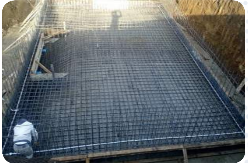
Fotoğraf- 133-134 Çarşıbaşı Şahinli-Kavaklı Grup İçme Suyu Arıtma ve Şebeke Bakım-Onarım İnşaatı
