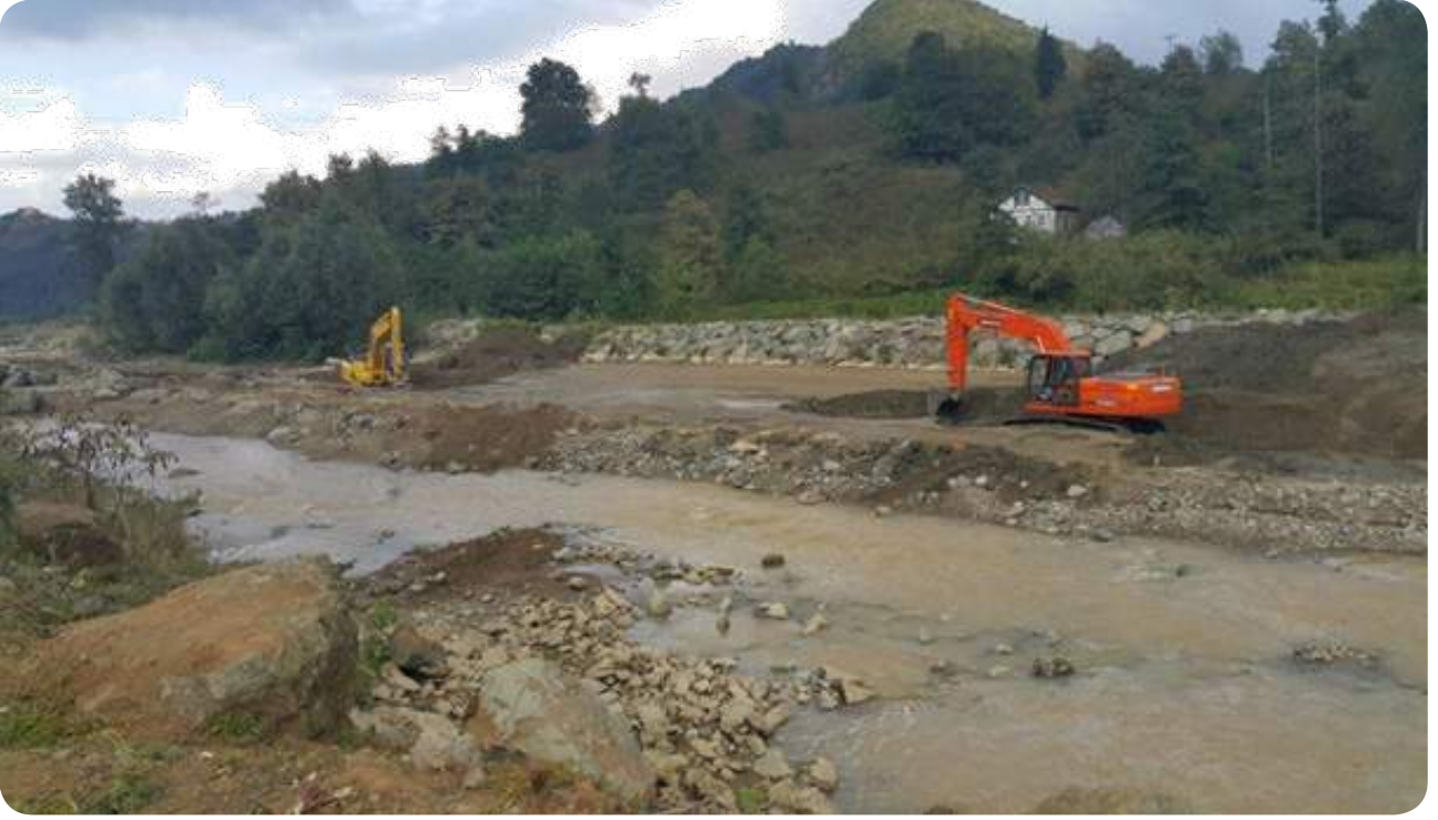
Fotoğraf- 64 Kuyuların daha verimli çalışabilmesi için temizlik çalışmaları yapılmıştır.
