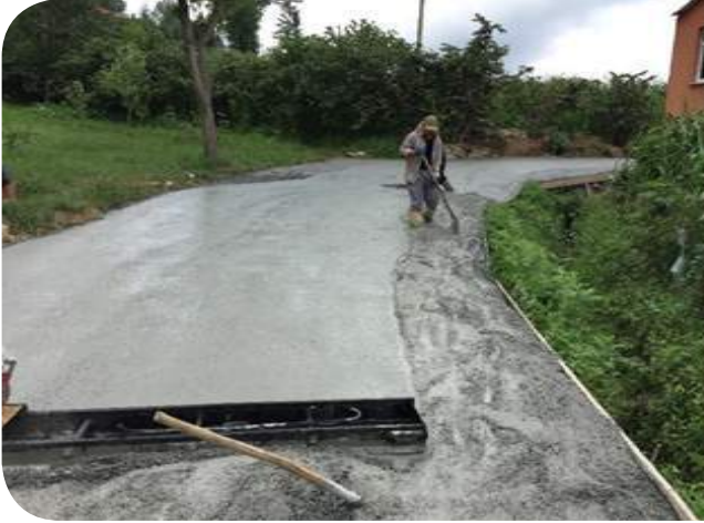
Fotoğraf- 174-175-176-177 İçme Suyu ve Kanalizasyon Nedeniyle Bozulan Beton Yol Bakım ve Onarımı (120.000 m 2 )
