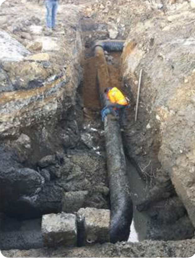
Fotoğraf- 119-120-121 Muhtelif Küçük İçme Suyu İnşaatı İşleri
