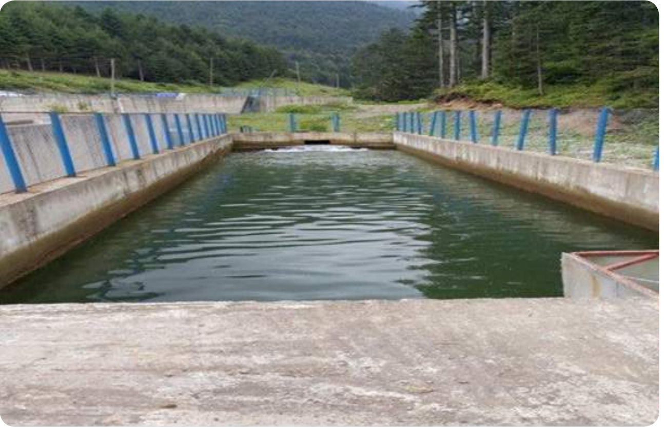
Fotoğraf- 65 Su alım yapıları temizlenerek verimli hale getirilmiştir
