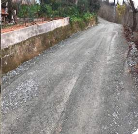
Fotoğraf- 178-179-180-181-182-183 İçme Suyu ve Kanalizasyon Arızalarından Dolayı Bozulan Stabilize Yol Bakım Onarımı (160.000 m2)
