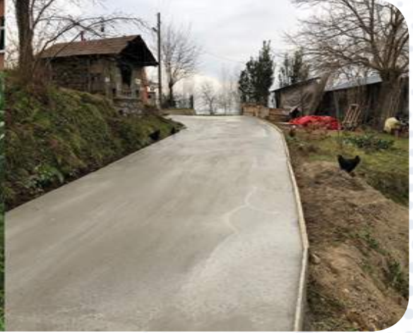
Fotoğraf- 174-175-176-177 İçme Suyu ve Kanalizasyon Nedeniyle Bozulan Beton Yol Bakım ve Onarımı (120.000 m 2 )
