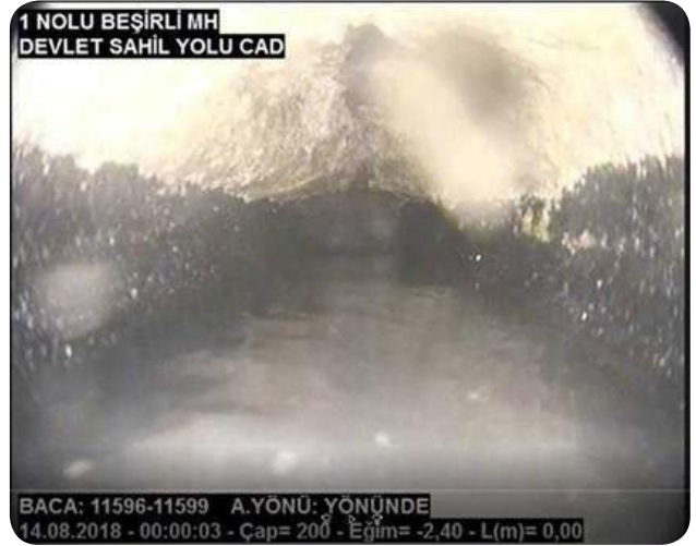
Fotoğraf- 104 1 Nolu Beşirli Mahallesi Devlet Sahil Yolu Kanal Görüntüleme Çalışması
