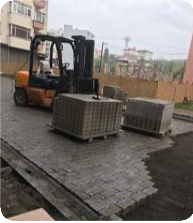
Fotoğraf- 189-190-191 İçme Suyu ve Kanalizasyon Arızalarından Dolayı Bozulan Parke Yol Tamirâtı (65.000 m2)
