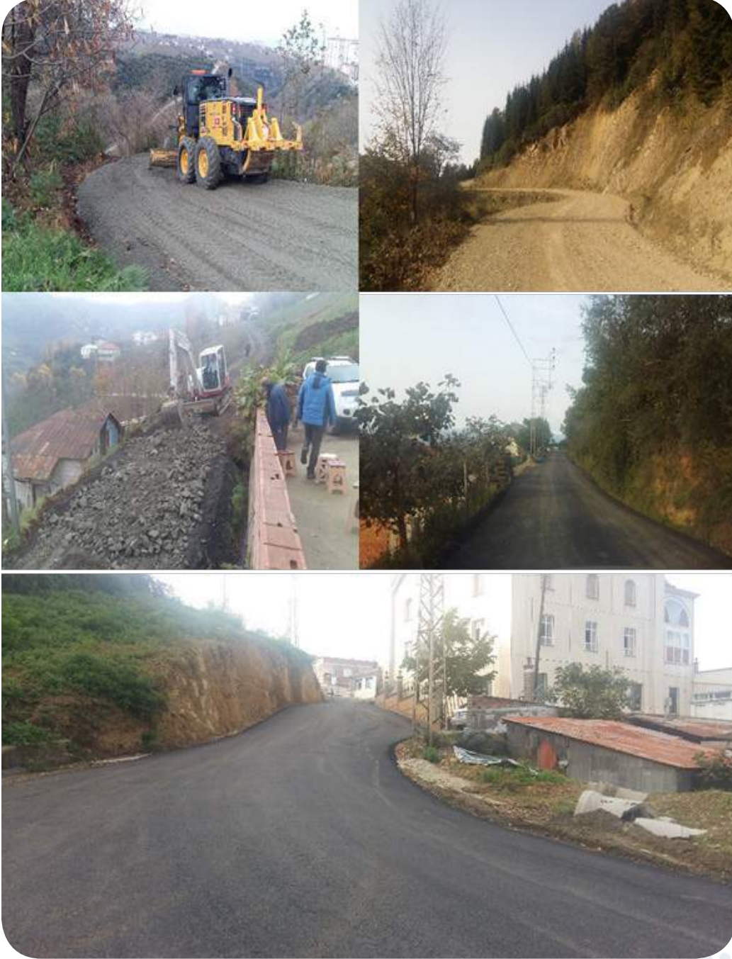
Fotoğraf- 184-185-186-187-188 İçme Suyu ve Kanalizasyon Arızalarından Dolayı Bozulan Stabilize Yol Bakım Onarımı (160.000 m 2 )
