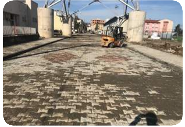
Fotoğraf- 189-190-191 İçme Suyu ve Kanalizasyon Arızalarından Dolayı Bozulan Parke Yol Tamirâtı (65.000 m2)
