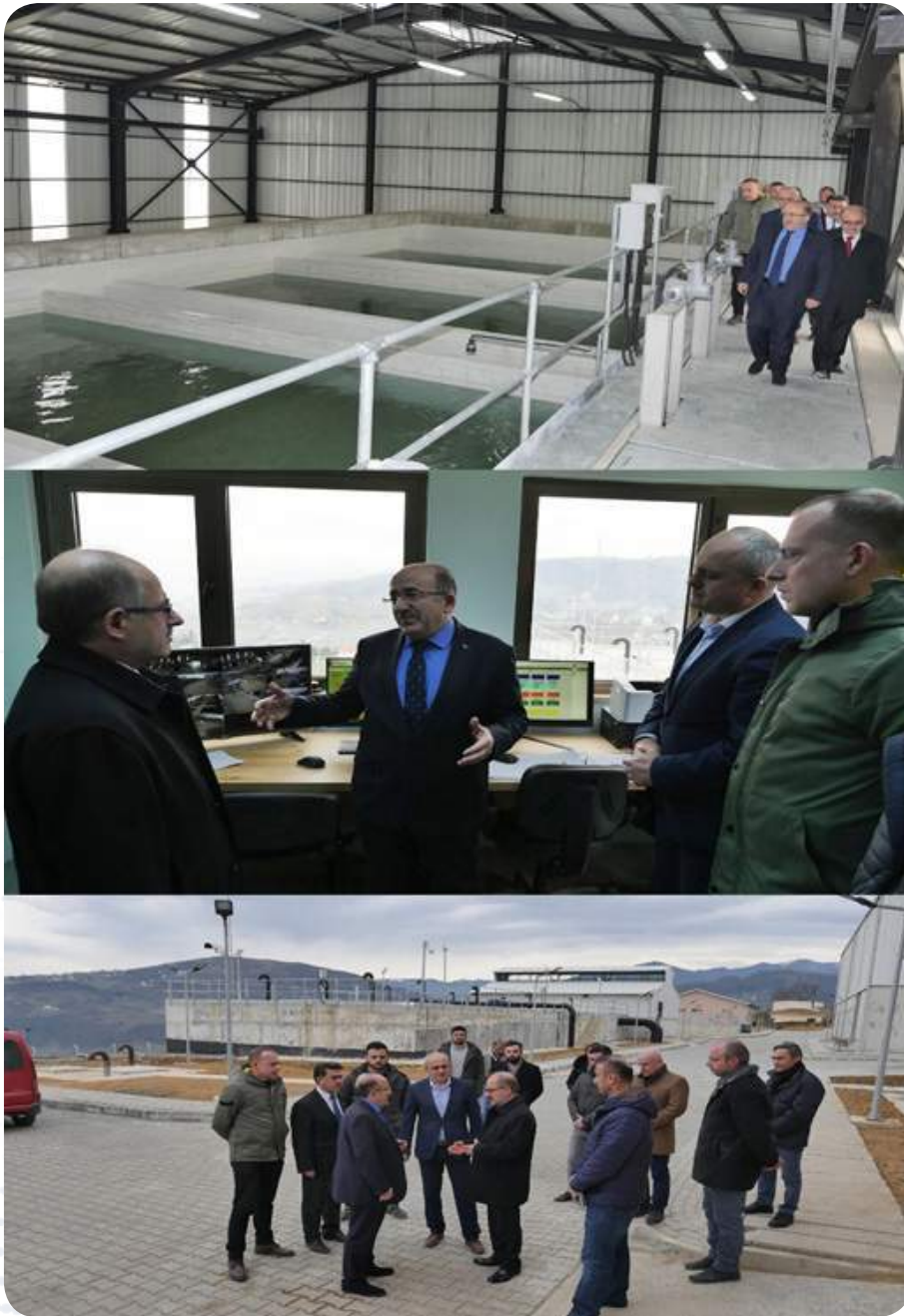
Fotoğraf- 140-141-142 Akçaabat (Trabzon) İçme Suyu Temin Sistemi Tamamlama İnşaatı İş Saha Ziyareti
