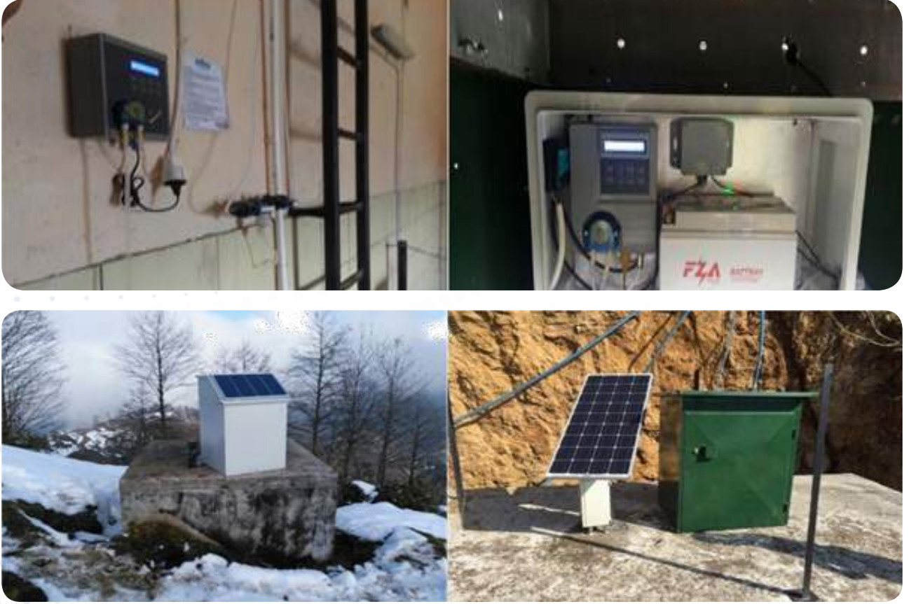
Fotoğraf- 82-83-84-85 Klorlama Cihazı Makinaları
